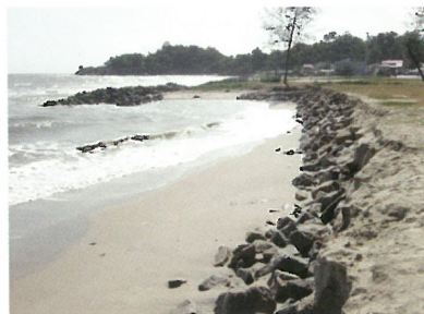
การแก้ปัญหาการกัดเซาะ โดยการสร้างเขื่อนกันคลื่น ทำให้การกัดเซาะลุกลามไปทางเหนือ ของหาดทราย (ภาพปี 2546) ที่มา: เครือข่ายเฝ้าระวังรักษาชายหาด
