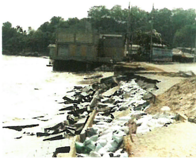
ผลกระทบจากบ่อสูบน้ำเสีย ต่อชายหาดชลลาทศน์ทำให้การกัดเซาะ ด้านเหนือของอาคาร (ภาพปี 2542) ที่มา: เครือข่ายเฝ้าระวังรักษาชายหาด
