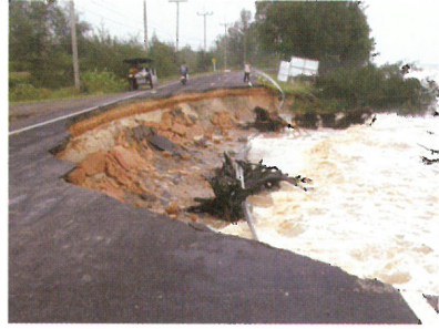
ผลกระทบจากเขื่อนกันคลื่น
