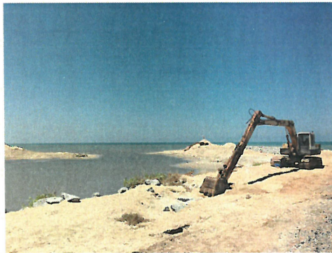
การขุดลอกร่องน้ำและถ่ายเททราย ร่องน้ำปานาเระ จ.ปัตตานี ดำเนินการโดยกรมเจ้าท่า
