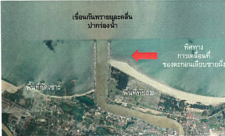
โครงสร้างเขื่อนกันทรายและคลื่นปากร่องน้ำสะกอม จ.สงขลา ก่อให้เกิดความเสียหายบริเวณชายหาดถัดไป
