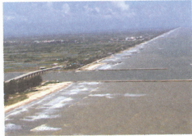
ปี 2547 สร้างเขื่อนกั้นทรายปากคลองชะอวด- แพรกเมือง ซึ่งอยู่ทางทิศใต้ของบ้านหน้าศาลเป็น ระยะทางราว 1 ก.ม.
