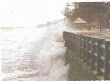
ปี 2549 เปลี่ยนเป็นกำแพงชายฝั่ง เป็นผลให้หาดทราย ถูกกัดเซาะรุนแรงขึ้นในฤดูมรสุม ชายฝั่งที่สูงงูเลีย หาดทรายทำให้คลื่นโถมเข้าหากำแพงโดยไม่มีหาด ทราย ช่วยดูดซับความแรง
